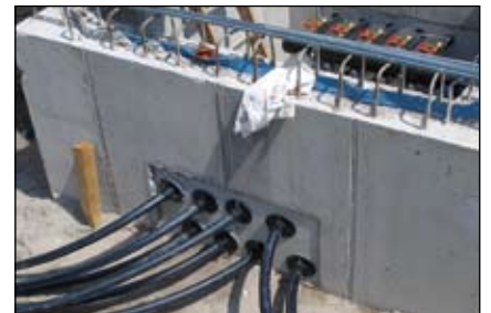
Flex 310 M – Sigillatura di un passaggio di tubi
