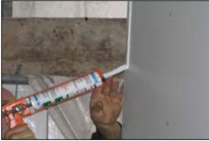
Flex 310 M – Incollaggio di lastre di poliestere a lastre di acciaio inox
