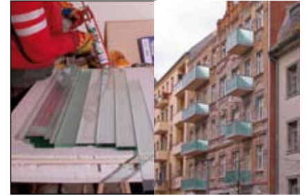
Flex 310 M Crystal – Incollaggio di lastre di vetro
