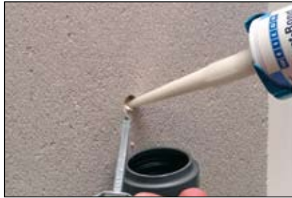
Fast-Bond – Fissaggio di un morsetto da parete ad un pannello
