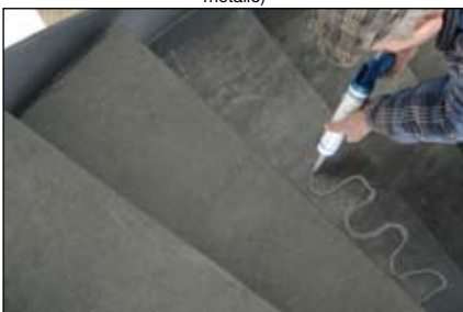
Flex 310 M – Incollaggio di granito a lamiera di acciaio (scale)
