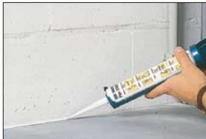
Flex 310 – Sigillatura di vuoto fra parete e pavimento
