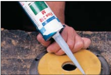
Flex 310 M – Sigillatura di perdite in parti di poliuretano
