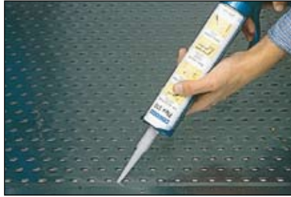
Flex 310 – Sigillatura di giunti in una camera refrigerata
