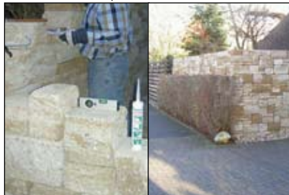
Flex 310 M Crystal – Incollaggio di blocchi di arenaria
