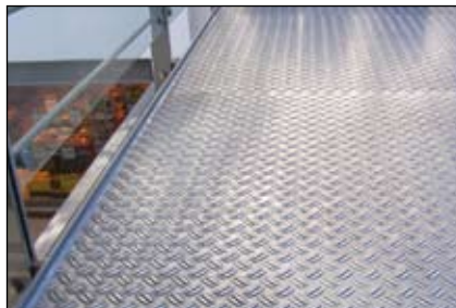
Flex 310 M – Incollaggio di piastre di alluminio ad una pavimentazione
